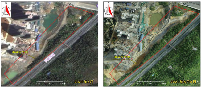
图1 边坡坍塌事故前后对比图
